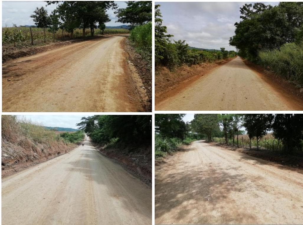
**Figura 4.6.** Registro fotográfico del tramo asignado al producto puzolánico zeolita/cemento después de intervención
