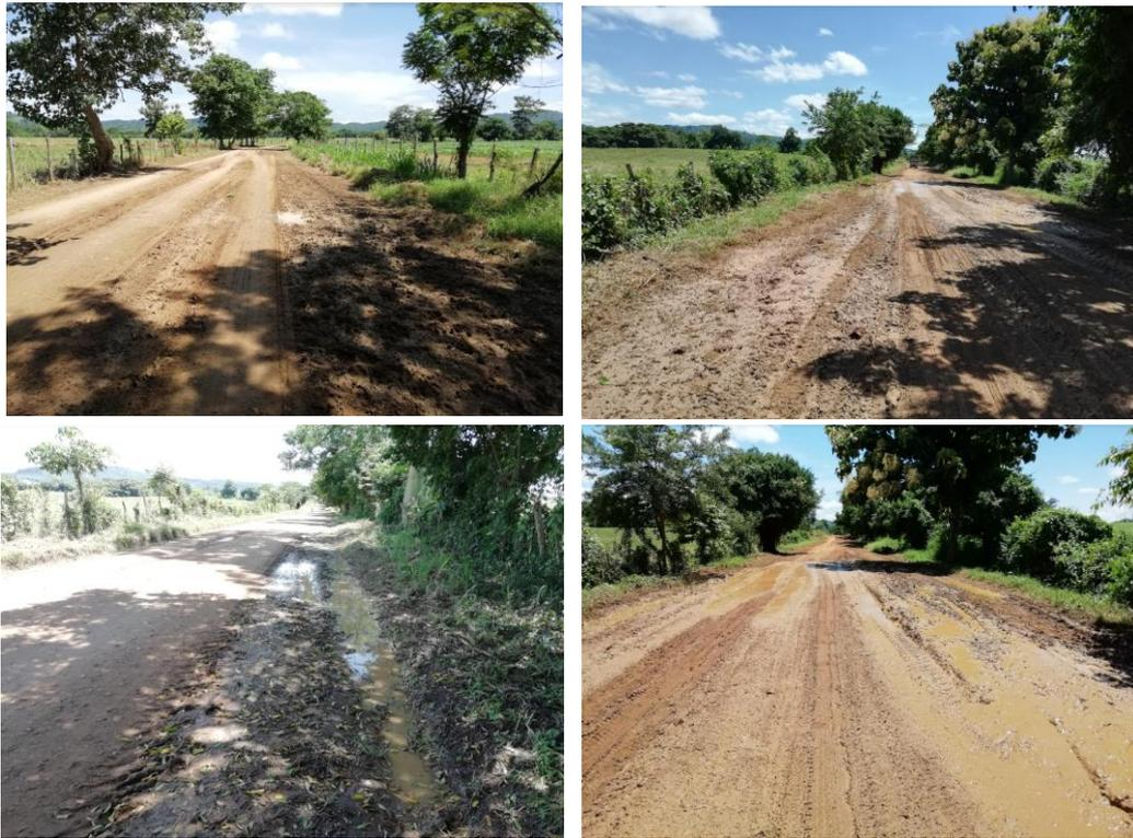
**Figura 4.5.** Registro fotográfico del tramo asignado al producto puzolánico zeolita/cemento antes de intervención
