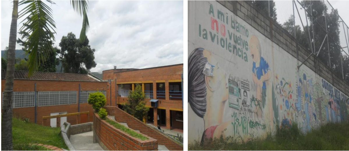
Figura 3. Institución Educativa Sol de Oriente (Interior y fachada. 2014)
