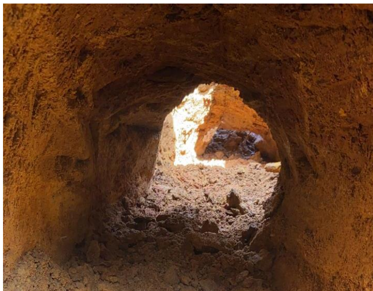
Túnel excavado por debajo de placa huella para cruce de tubería de un lado a otro de la vía.
