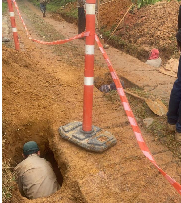
Excavación de túnel por debajo de placa huella.
