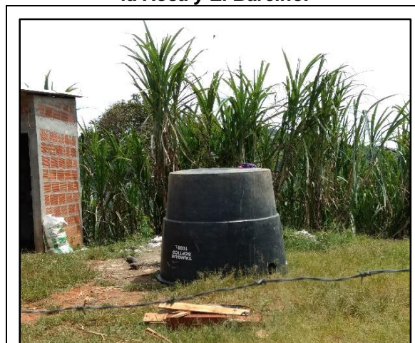
Pozos sépticos presentes en las veredas, lo cuales no reciben un uso adecuado, o simplemente no se implementan. Fotografía tomada el 06 de junio de 2018.
