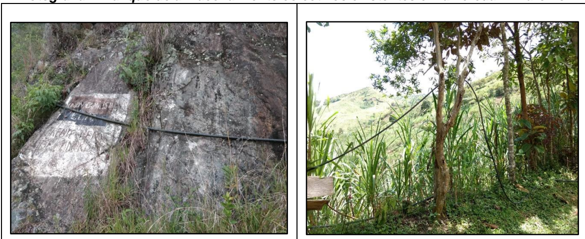
Redes de aducción-conducción no convencionales presentes en las veredas Guaduas, Plan de la Rosa y El Barcino, realizadas con mangueras de agricultura de ½” y 1” de diámetro. . Fotografía tomada el día 27 de febrero de 2018.
