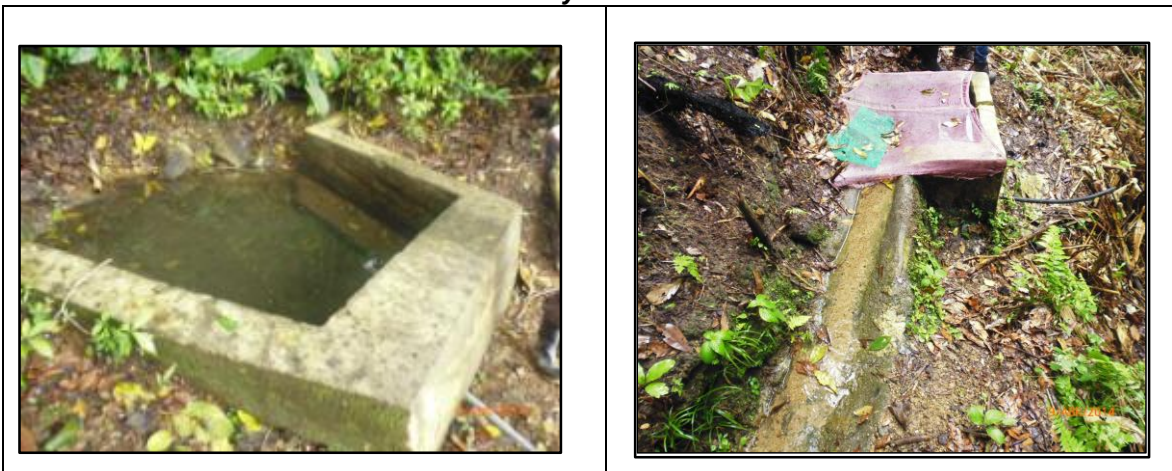
Captaciones artesanales encontradas en el área de estudio para represar el agua de los nacimientos abastecedores.
