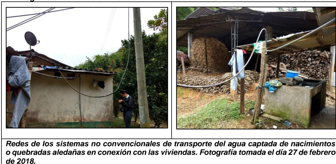
Fotografía 6. Redes de distribución artesanales en conexión con una de las viviendas.
