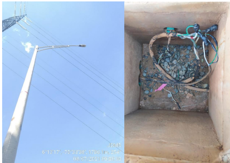
Fig. 3: Registro fotográfico de visita a obra en ejecución de una obligación urbanística.
