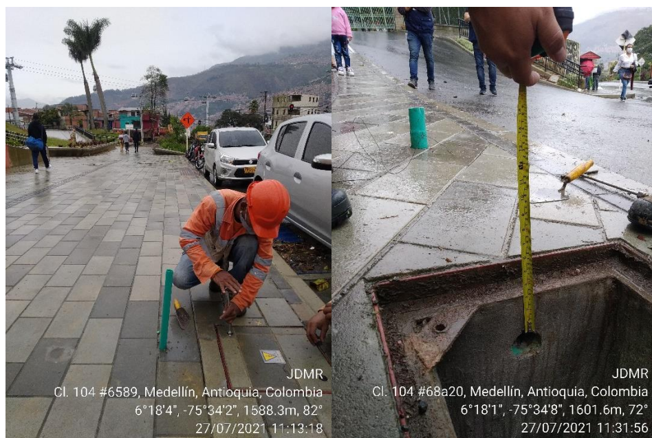
Fig. 2: Registro fotográfico de visita a obra en ejecución de un proyecto estratégico.
