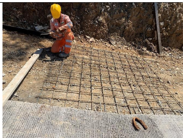
Foto 011. Refuerzo corrugado en losas y sobre anchos
