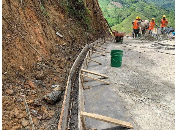
Foto 013. Construcción cuneta
