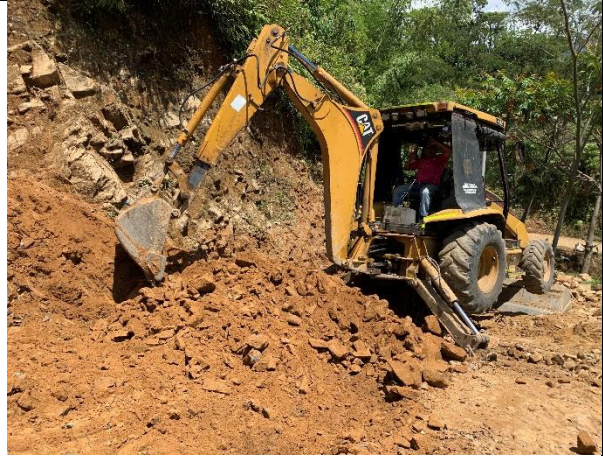
Foto 002. Excavación a maquina
