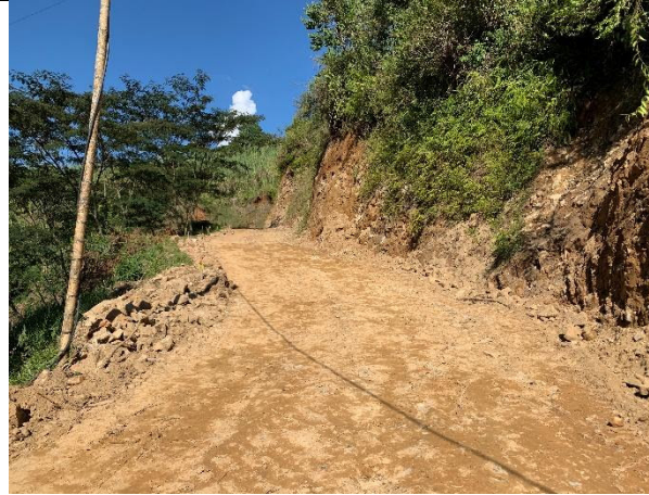
Foto 001. Perforación y nivelación de terreno
