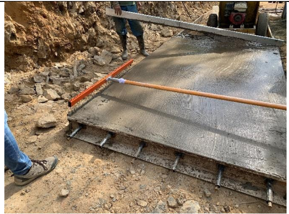
Foto 008. Texturizado del concreto
