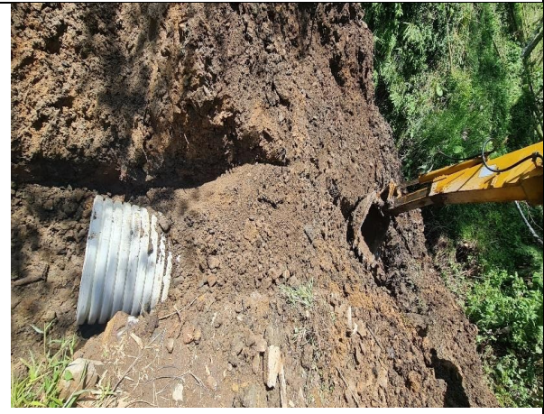
Foto 004. Llenos con material de excavación
