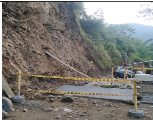
Foto 015. Construcción de dentellón
