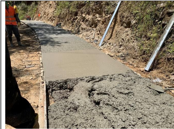
Foto 007. Concreto para pavimento MR4
