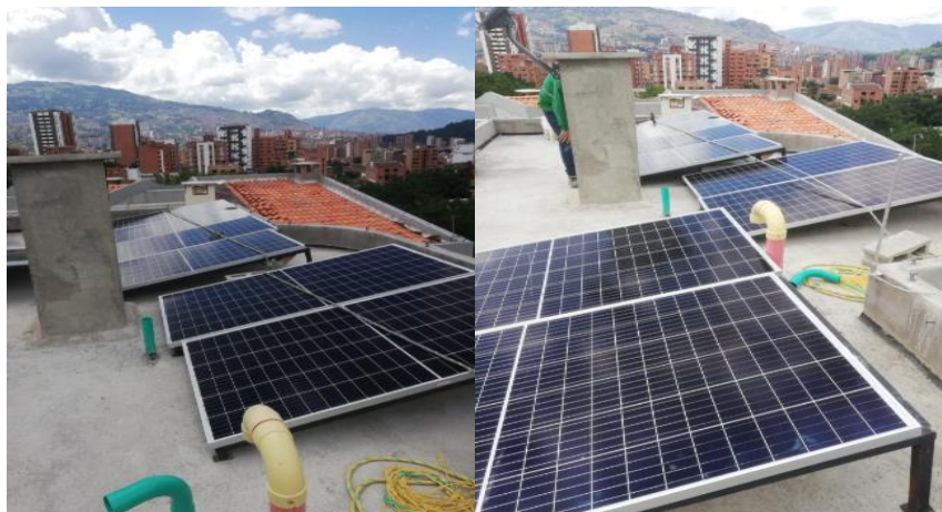
Instalacion de paneles solares edificio Hojarasca
