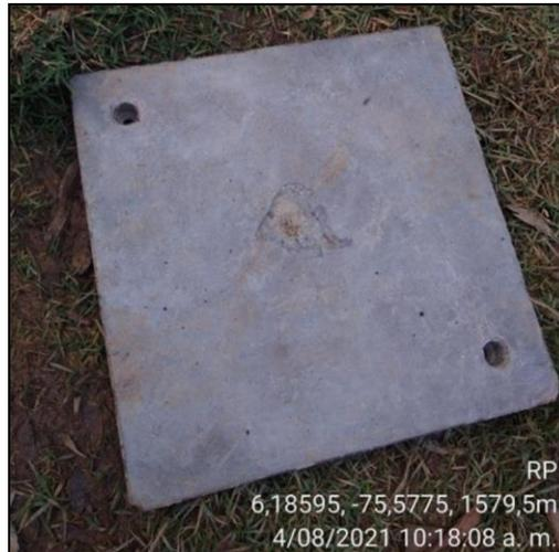
Fig. 4. Observación en terreno: Falta símbolo eléctrico en la tapa de la caja.
