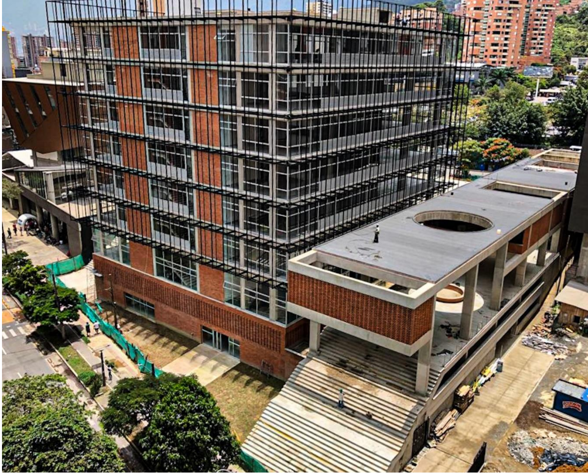
Evidencia 12 Fachada occidente y sur.
