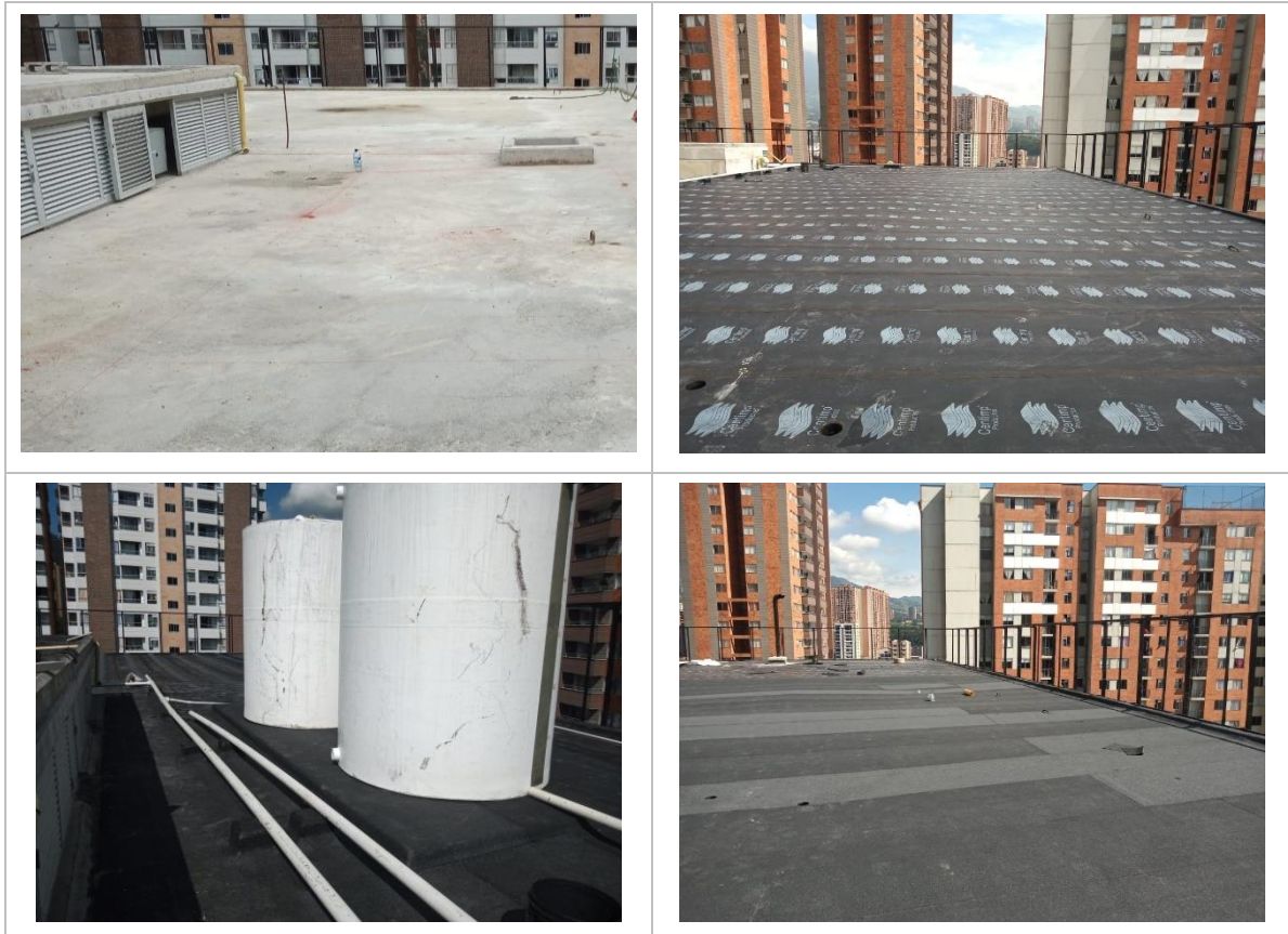
Evidencia 1 Impermeabilización en cubiertas.
