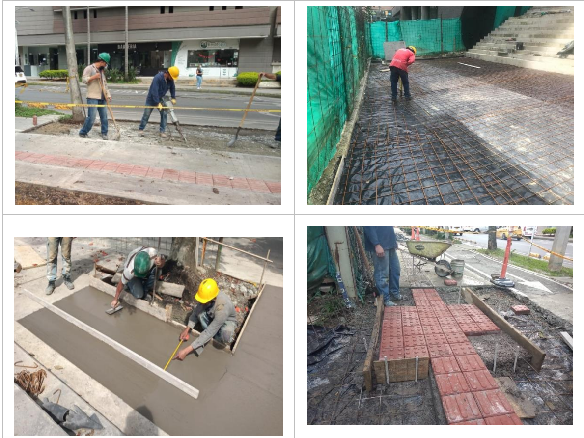
Evidencia 4 Construcción de andén.
