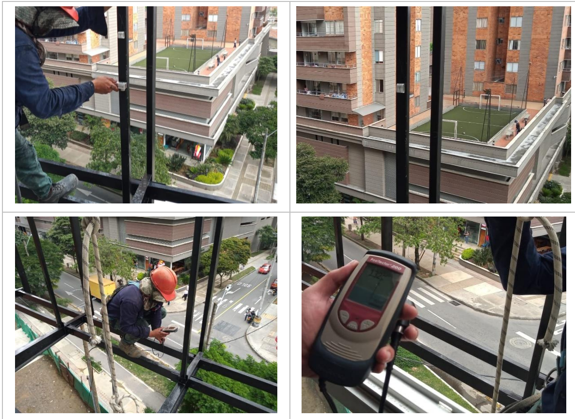
Evidencia 10 Ensayo de adherencia y espesor de pintura.
