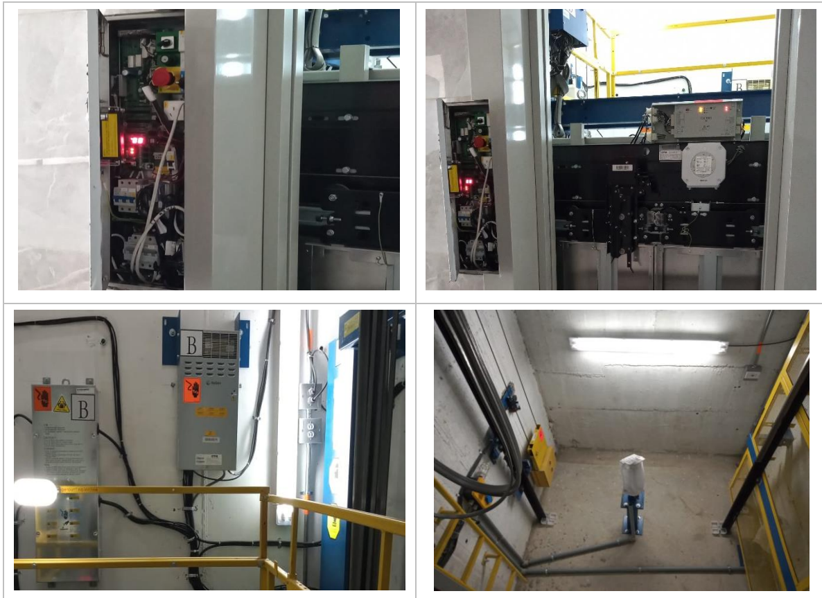
Evidencia 9 Inspección técnica.
