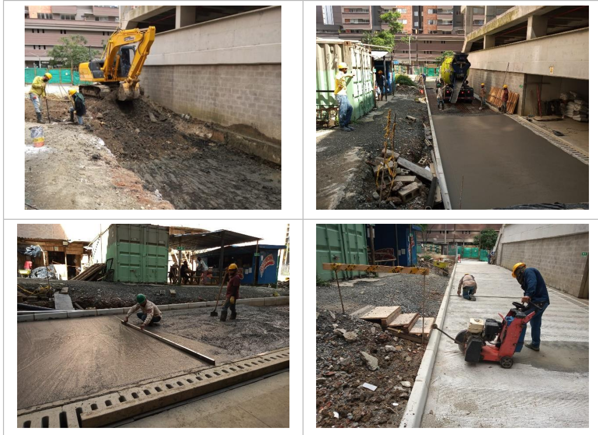
Evidencia 3 Construcción de vía.
