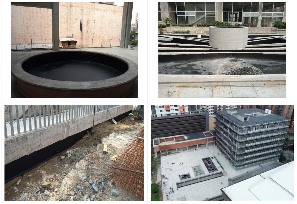
Evidencia 6 Impermeabilización con pintura asfáltica.
