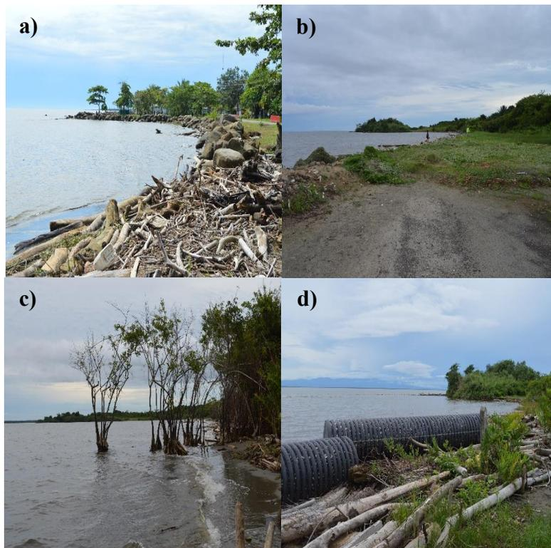
**Figura 5.** a) Enrocado realizado por la universidad EAFIT y CORPOURABA. b) Pista de aterrizaje afectada por la erosión en la Escuela de Combate Fluvial (ESCOFLU). c) Vegetación presente. d) Geotubos utilizados como protección costera cerca de ESCOFLU (Longitud del tubo  $\approx 2,5$  m). Fotos tomadas por el proyecto “Erosión Costera” (Gobernación de Antioquia, Universidad Nacional de Colombia y Universidad de Antioquia, 2018).
