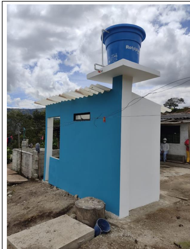
Suministro de pintura
