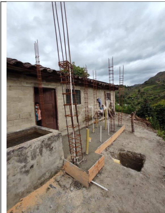
Fundición placa de Piso e instalación de redes hidrosanitarias
