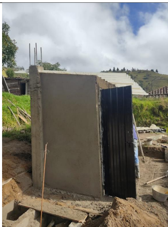
Suministro de carpintería metálica
