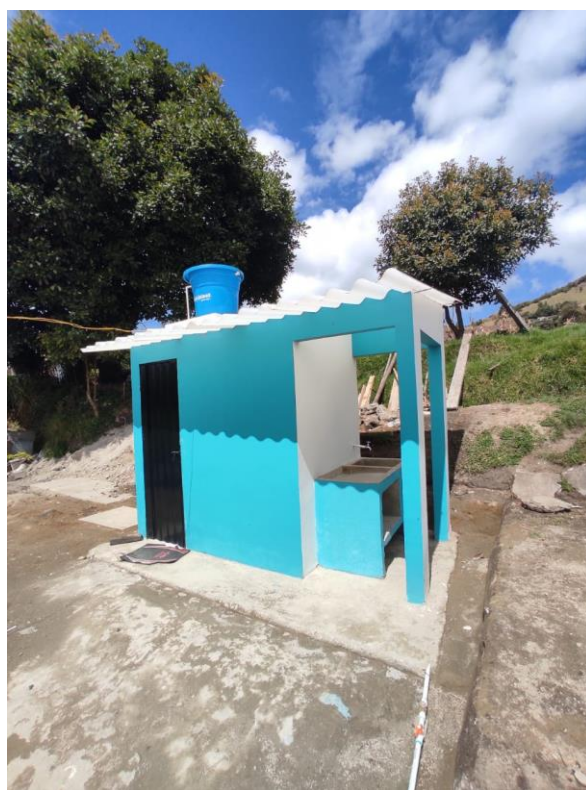
Unidad Sanitaria terminada
