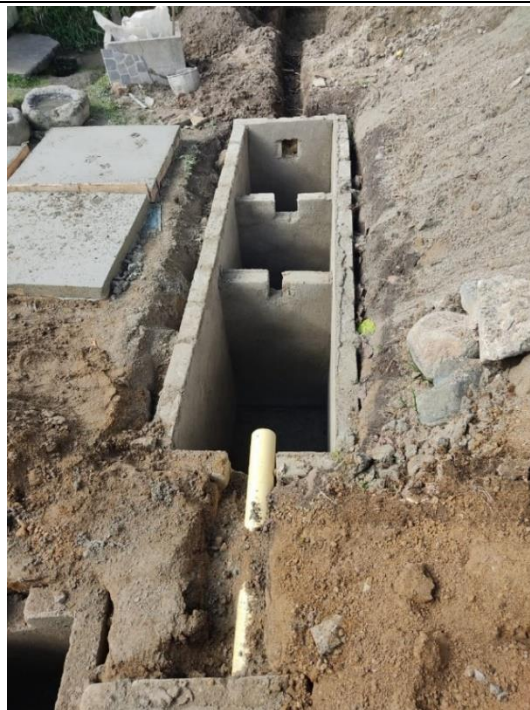
Levantamiento de muros y suministro de pañete pozo séptico y FAFA
