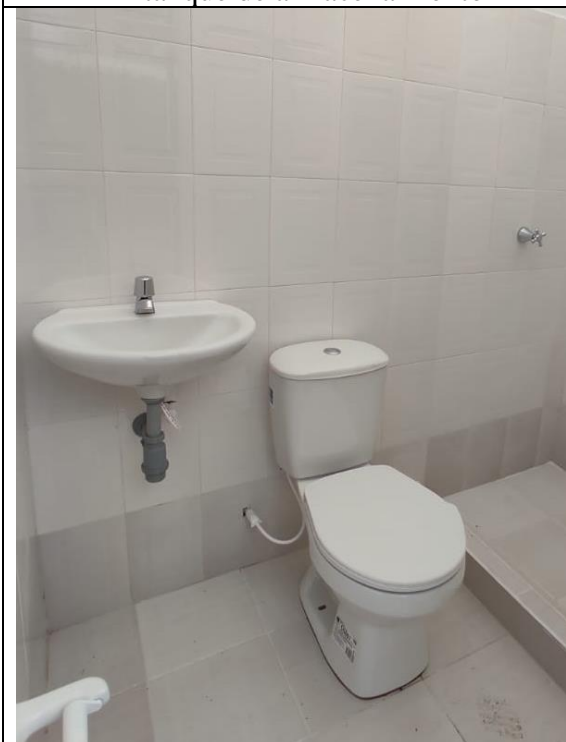
Instalación de aparatos sanitarios
