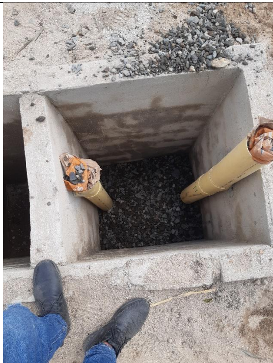
Suministro tubería y lecho filtrante para el FAFA
