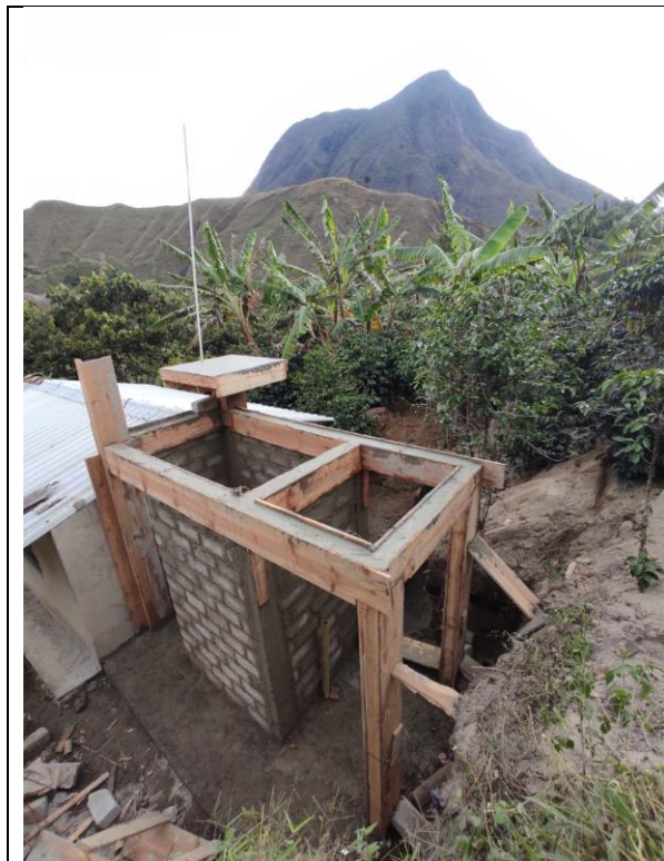
Fundición de vigas aéreas y Losa para Tanque
