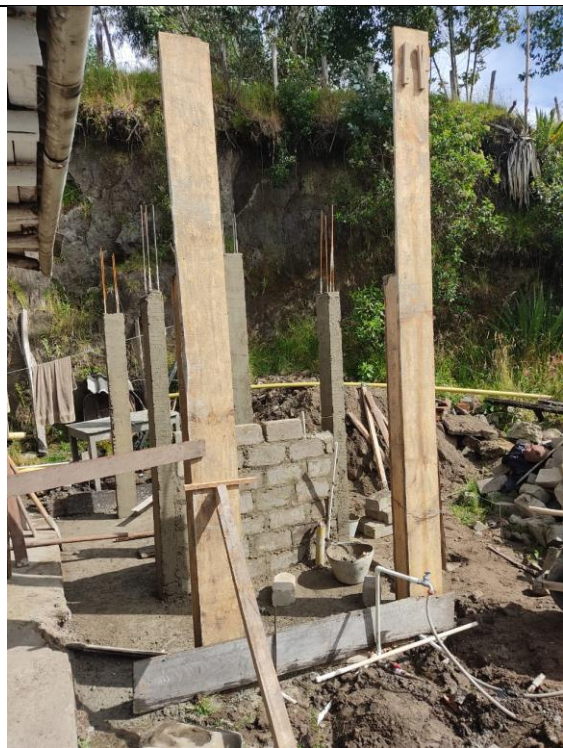
Fundición de Columnas
