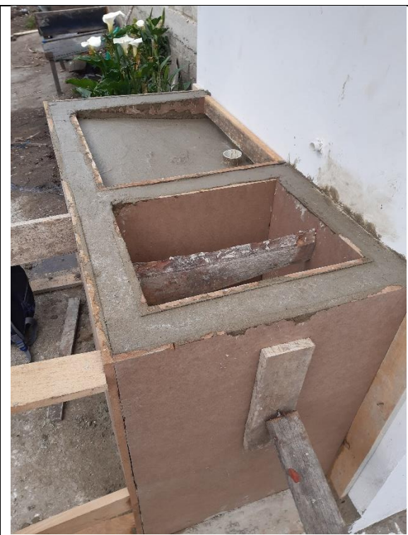
Fundición de Lavadero
