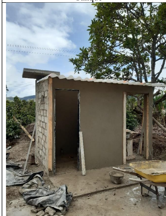
Suministro de pañete liso sobre muro
