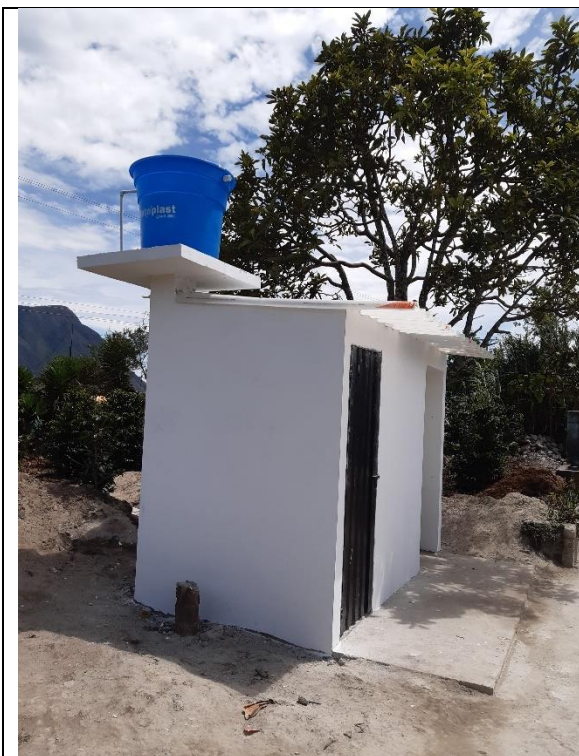
Suministro de estuco plástico e instalación de tanque de almacenamiento
