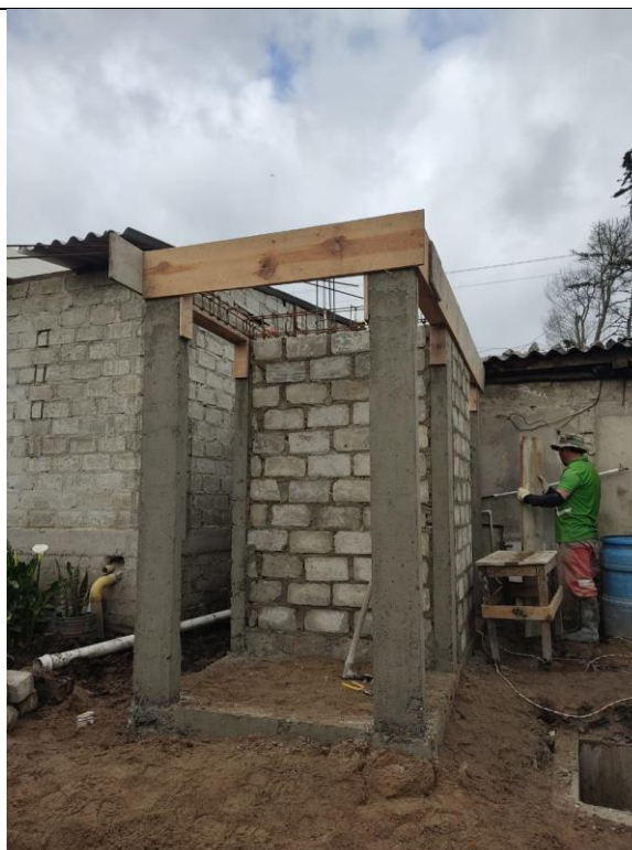
Colocación Acero de refuerzo vigas aereas
