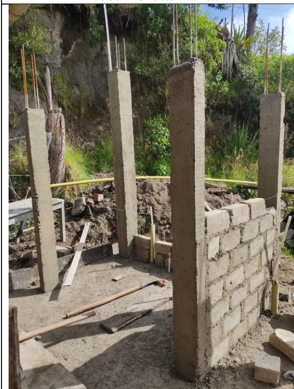
Levantamiento de Muros
