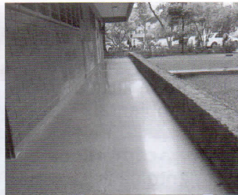
Pasillos del bloque 18 que fueron reparados.
