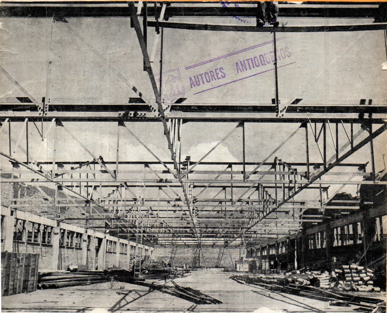
MODERNA ESTRUCTURA METALICA. PARA LOS PODEROSOS ENSANCHES DE INDULANA — FOTO CARVAJAL.
