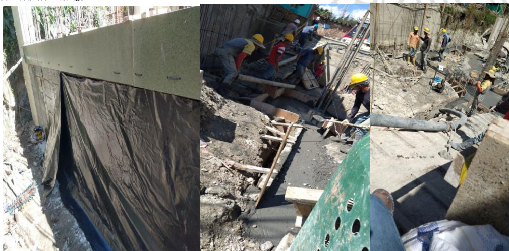
Obra en el mes de marzo
