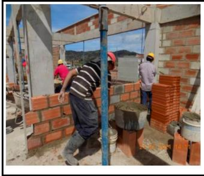
Muro divisor en losa 5, entre ejes B3 y C3
