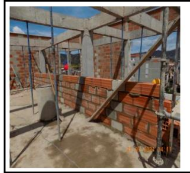
Divisor en losa 5, entre apartamentos 503 y 504
