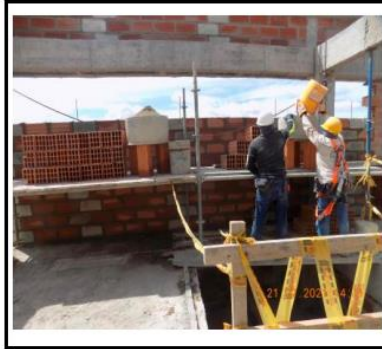
Perimetral en losa 5 entre ejes A3 y A4
