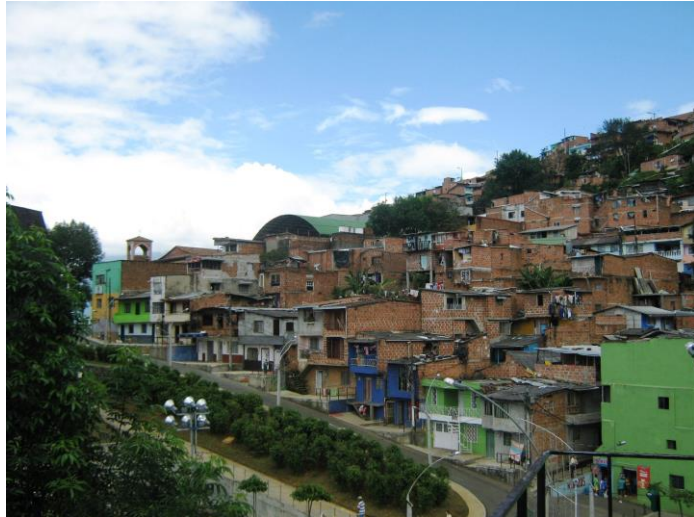
Fotografía Correa, A. (nov de 2008). Paseo peatonal de la 106A.
