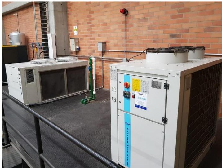
**Figura 20.** Chiller de 20 y 10 toneladas de refrigeración.
