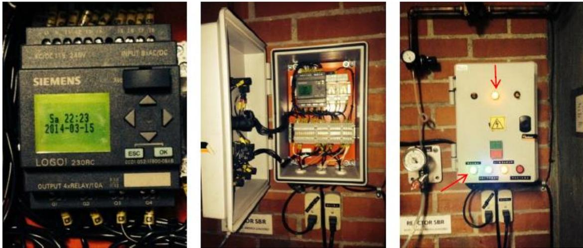
**Figura 4.6** Imagen de los principales componentes del sistema de control del SBR (Londoño, 2014).
