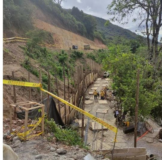
Para el mes de agosto se continua con la colocación de la primera capa de asfalto del PR 2+600 al PR 1 +320 y la instalación de la segunda capa de asfalto del PR 2+600 al PR 3+400, de igual manera se continua y se finaliza la construcción de los anillos para los caissons del muro 1 y del muro 5, se realizó la demolición de cunetas existentes del PR 0+494 al PR 0+600 y la construcción de filtros longitudinales y transversales en este sector.
