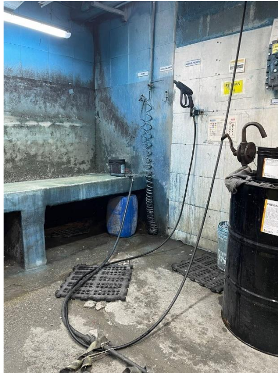
Fig 19. Proceso de remoción y limpieza de pantallas
