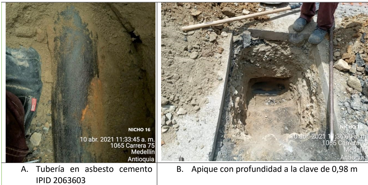
Ilustración 6. Nicho 16 positivo para asbesto cemento con diámetro 4”.
