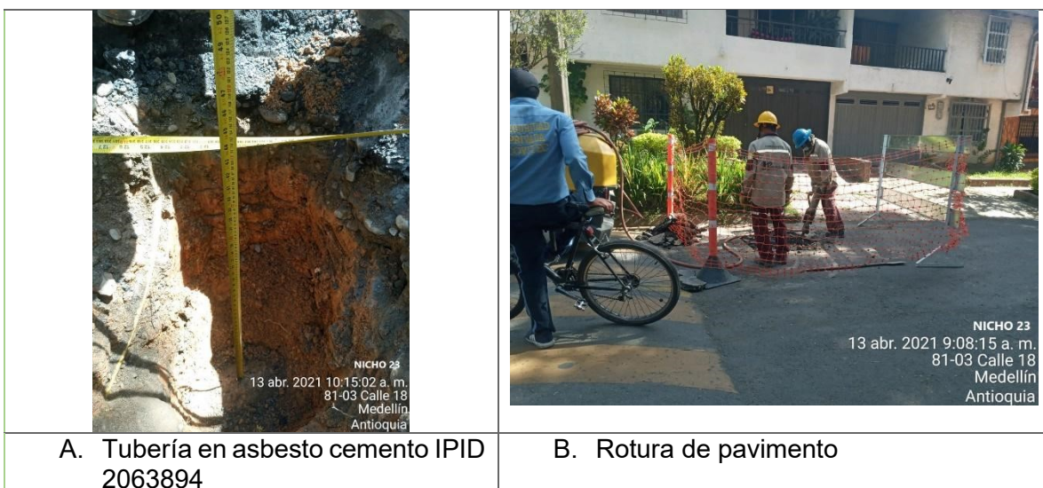
Ilustración 6. Nicho 16 positivo para asbesto cemento con diámetro 4”.
