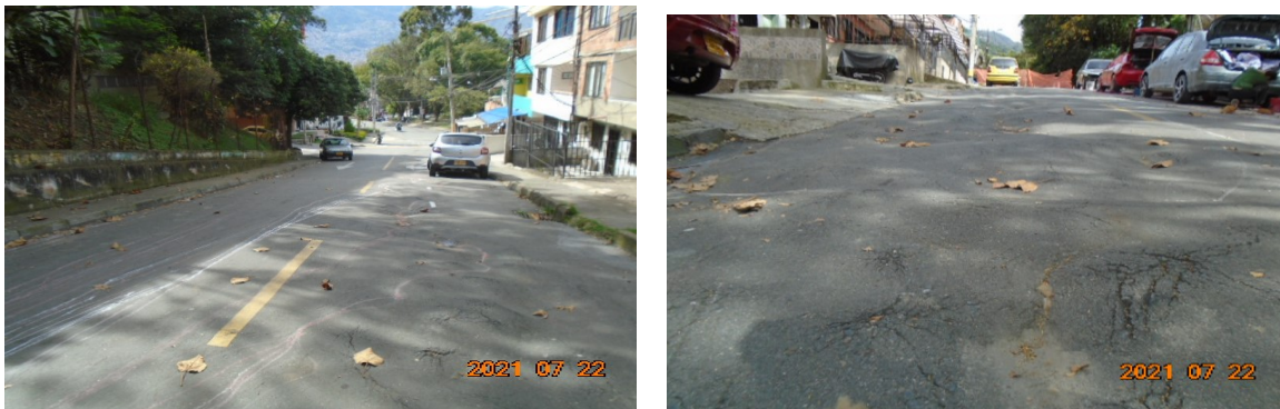
Ilustración 15. Panorámicas de la Calle 101C entre carreras 74B y 74A Barrio Pedregal.
