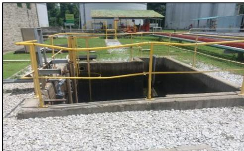
Este pozo cuenta con dos bombas centrifugas sumergibles (1 en servicio + 1 en reserva), boya de nivel la cual, alcanzando un nivel muy bajo, actúa como interruptor parando las bombas y sirviendo de protección de funcionamiento en seco (vacío).
