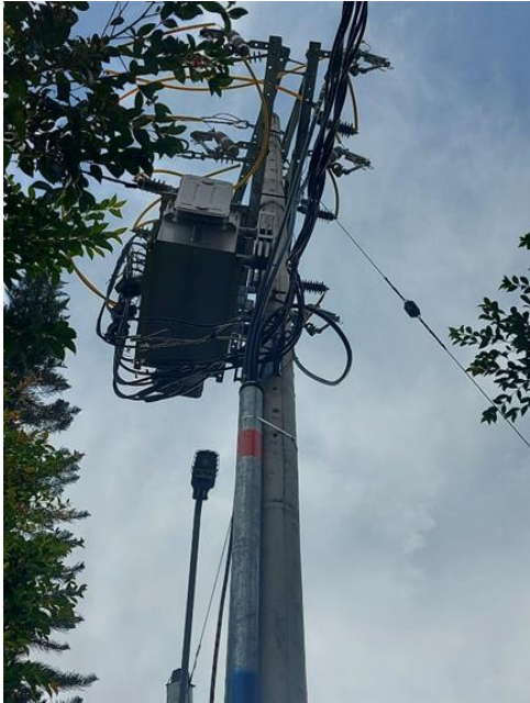
Fig. 34. Transformador de 112.5 kVA para desmontar.
