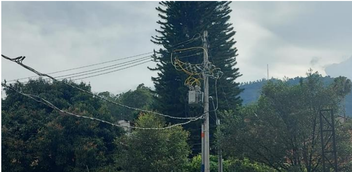
Fig. 36. Trenza provisional para desmontar.
