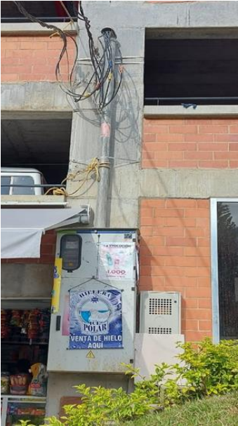
Fig. 35. Bajante y gabinete provisional para desmontar.
