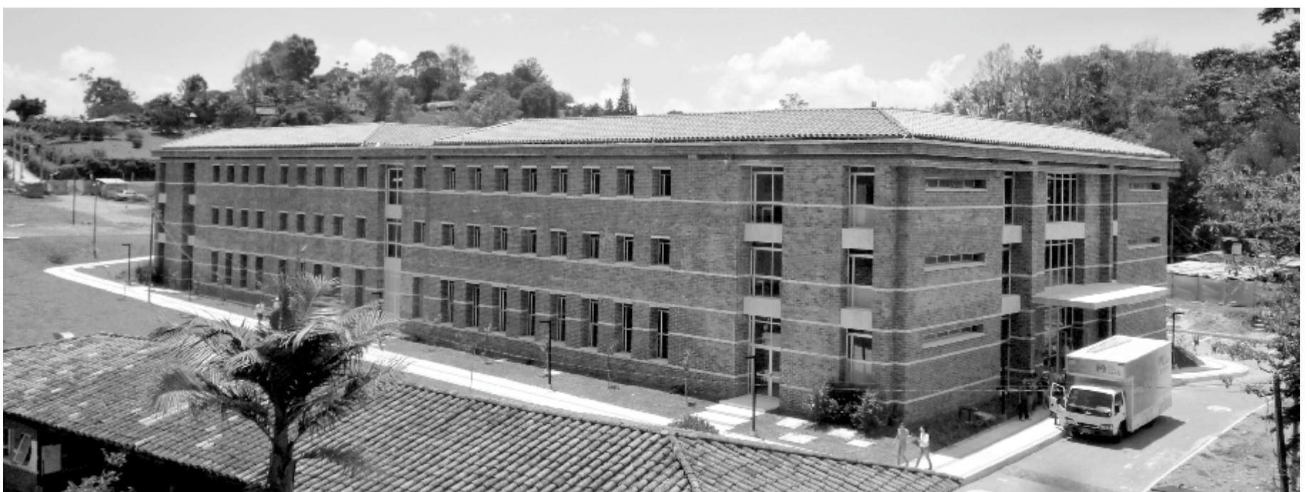
Nuevo Bloque 200, en la seccional Oriente, en el municipio de El Carmen de Viboral
