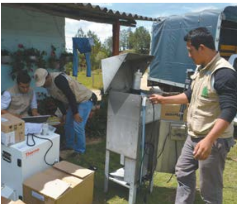
calibracion equipos antes de su instalacion
