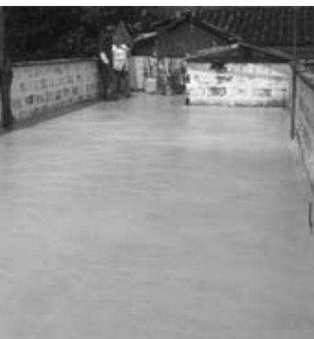
Superficies en las que se ha utilizado el impermeabilizante producido por los ingenieros.
