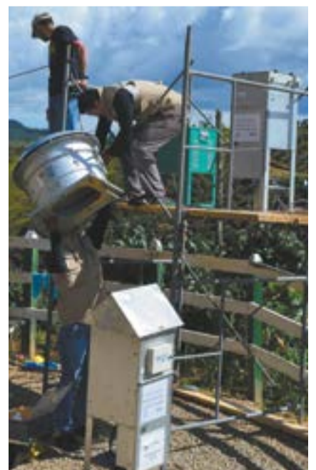
instalacion de puesto de monitoreo de aire
