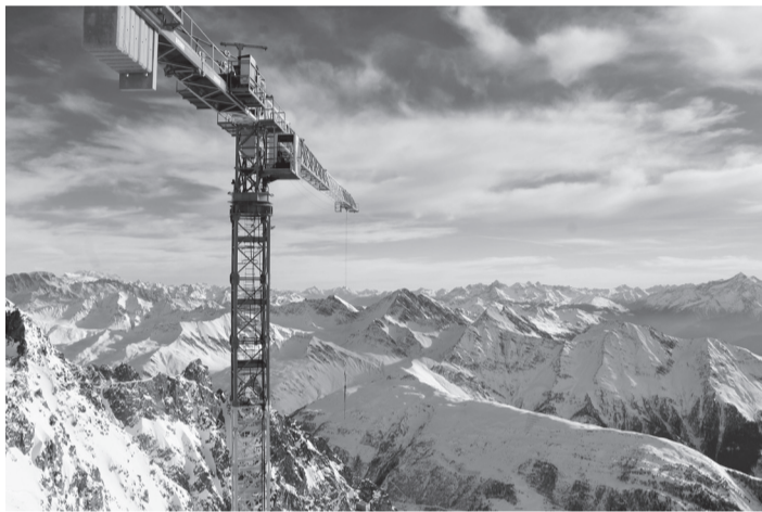
Segundo puesto: Hernán González Zapata Ingeniería Civil. Doble Titulación: Politecnico di Torino (Italia)
