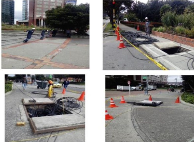
Figura 5. Tendido de fibra canalizado. A) halado de fibra B) zona de trabajo C) recamara abierta D) proceso de cierre de la recamara. Extraído de [3]
