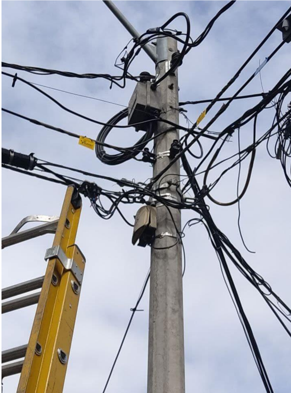
Figura 17. Mantenimiento preventivo realizado a un poste con herrajería defectuosa.
