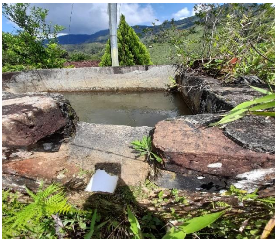
a) Punto de captación división sur
