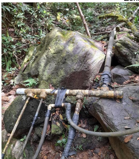
Punto de unión de mangueras
