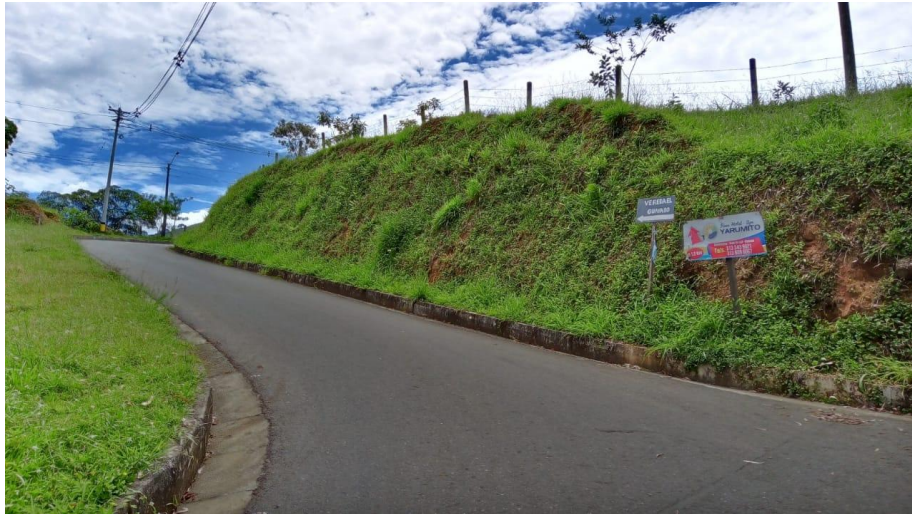
Figura 22. Vías con arrastre de residuos hacia la Quebrada Servidumbre la Fontana, Vereda Yarumito, Barbosa, 2021.
