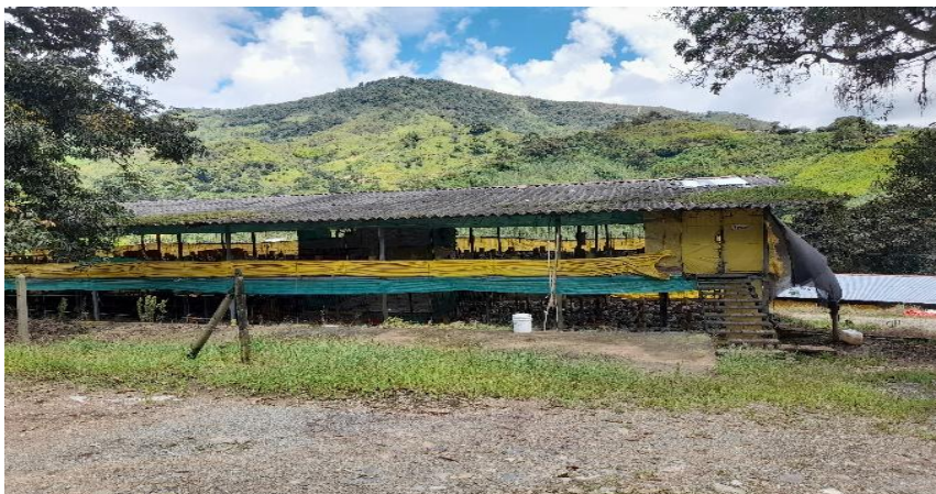
Figura 27. Granja avícola y tratamiento de agua residuales, Vereda Yarumito, Barbosa, 2021.
