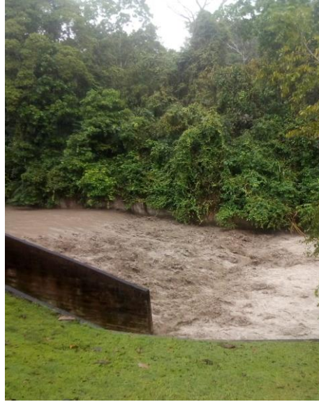
Ilustración 1. Fuente superficial, Rio Apartadó (Bocatoma).
