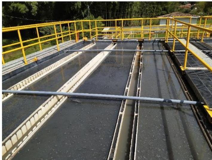
**Figura 7.** Sedimentadores de alta tasa de PTARD
