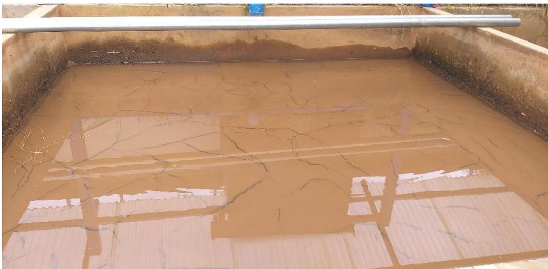
**Figura 4.** Lecho de secado de los lodos de potabilización
