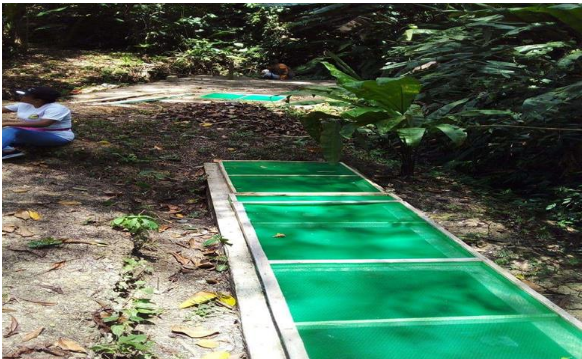
Filtro desarenador y pozo subterráneo de almacenamiento, Caribia. Fuente: archivo propio.
