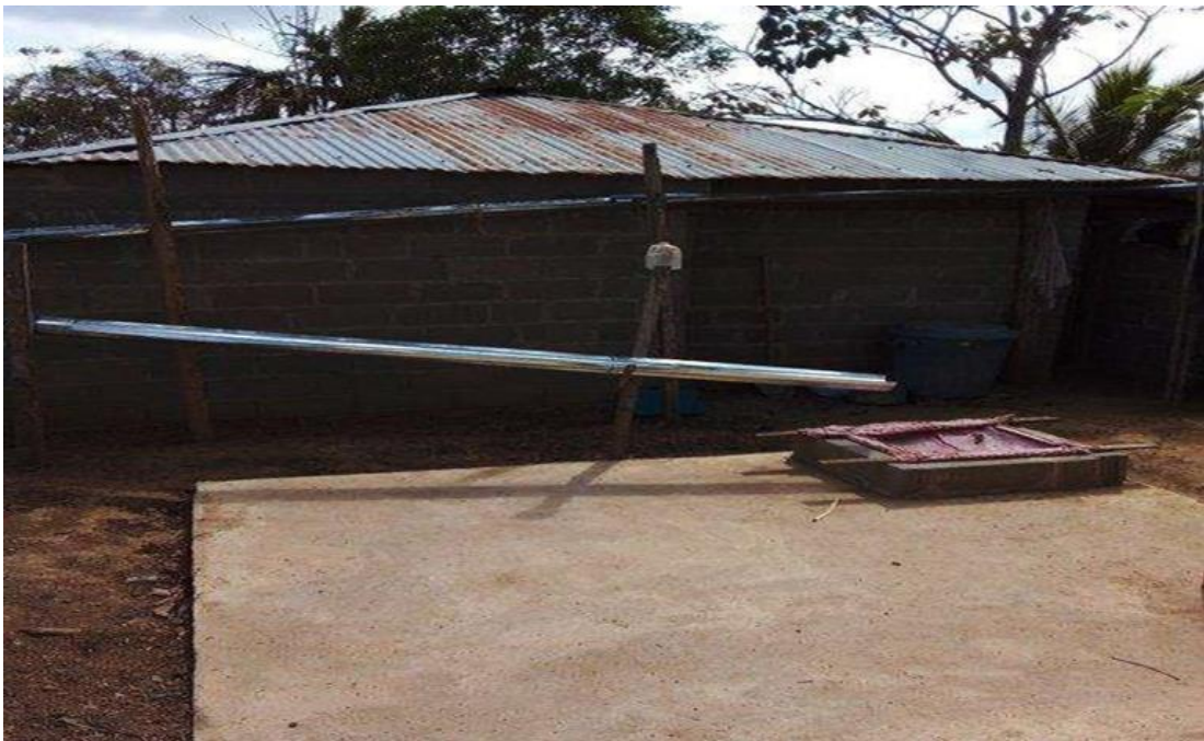
Aljibe y poceta subterránea - Buenos Aires. Fuente: archivo propio.
