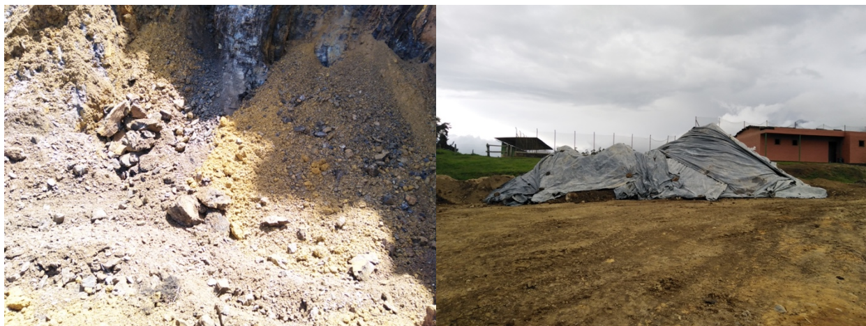
Fig. 13. Material agregado con contenido arcilloso - Protección de la humedad del ambiente.
