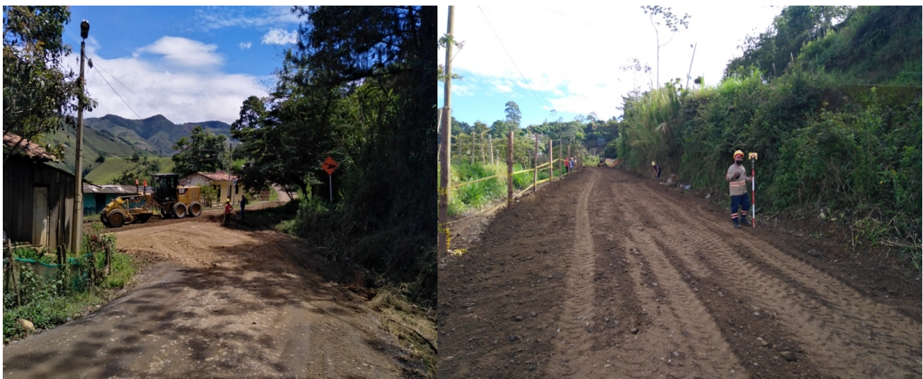
Fig. 3. Suministro, extensión y compactación de la base granular.
