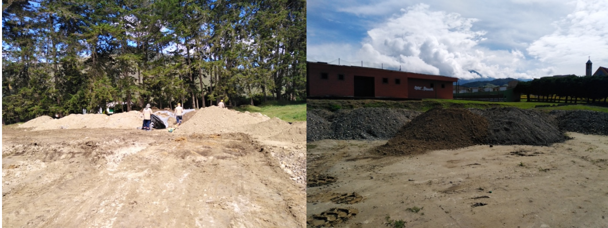
Fig. 2. Zona de almacenamiento de materiales barrio Jaiperá, municipio de Urrao, Antioquia.
