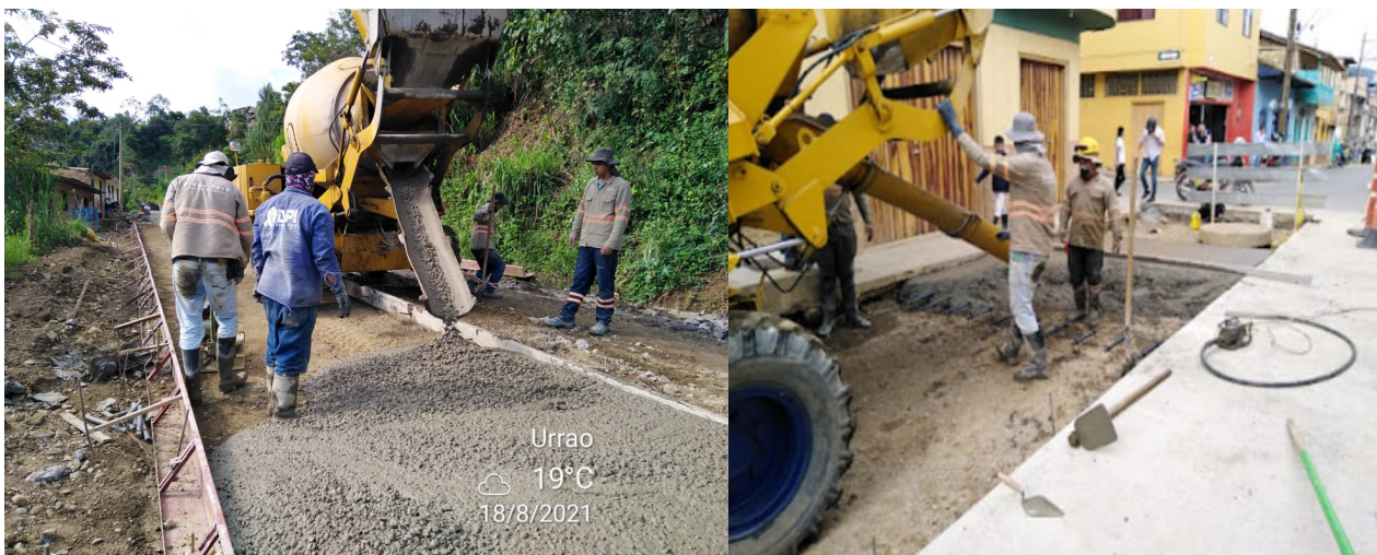
Fig. 7. Carmix empleada para el mezclado, transporte y extensión del concreto hidráulico
