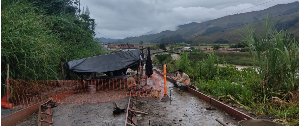
Fig. 8. Instalación de toldo de protección durante las épocas de lluvias en la obra
