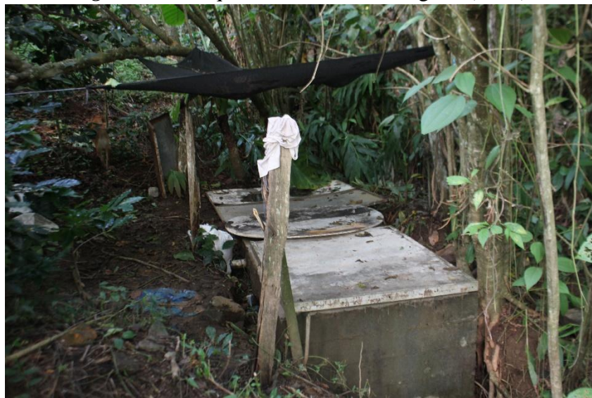
Figura 27. Tanque de nacimiento de agua. (2020)
