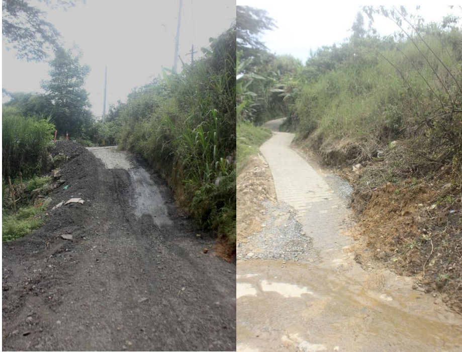
Figura 12. Estas son las dos entradas para vehículos a la vereda La Aldea Parte Alta por la Vía al Mar. (2021)
