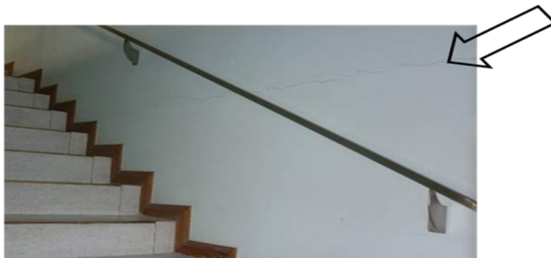
Figura 11. Escaleras segundo piso de la empresa Matec S.A.
