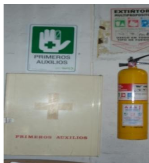
Figura 13. Extintores de la empresa Matec S.A.
