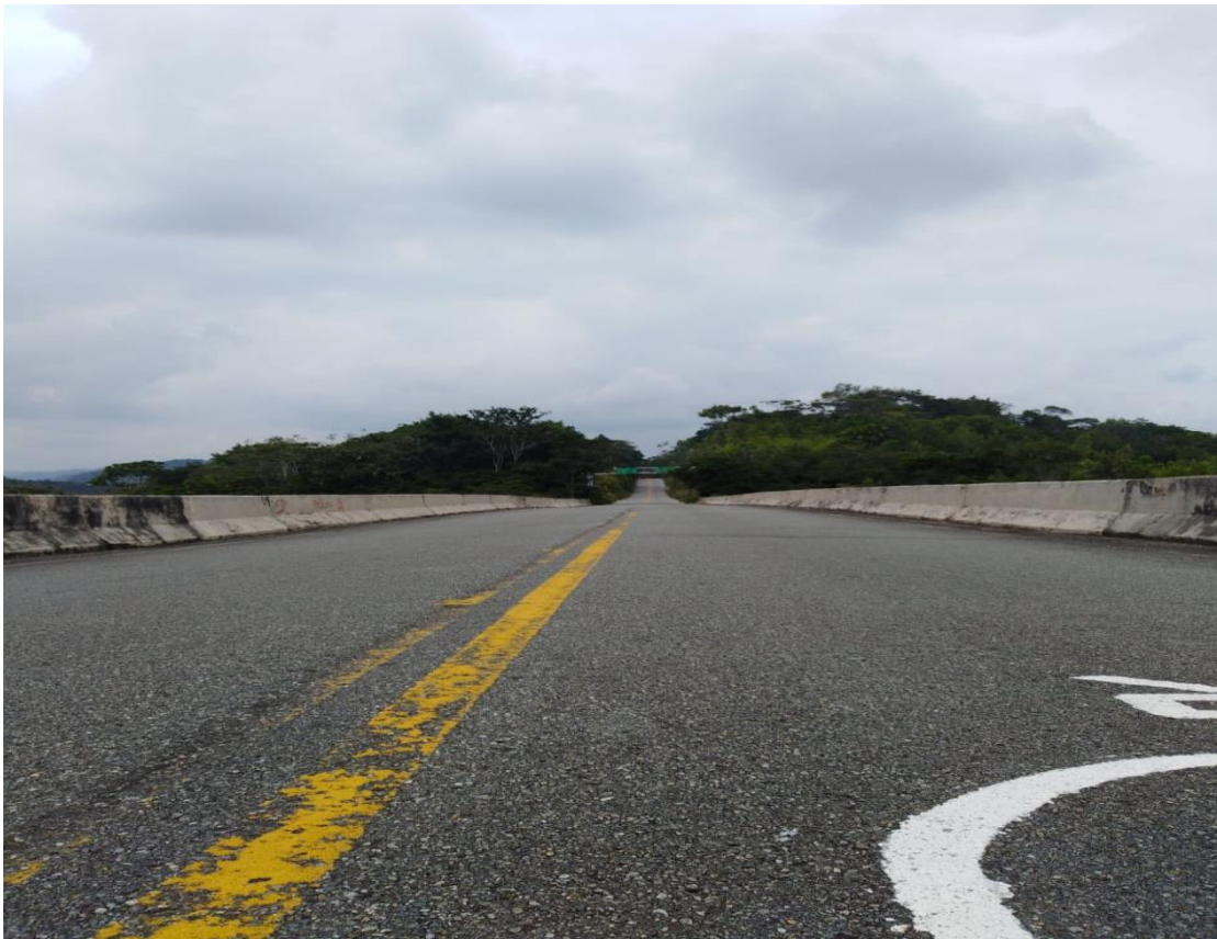
Figuras 12 Carretera construida por Isagen sobre Punte Danticas (Vía San Carlos-San Rafael)
