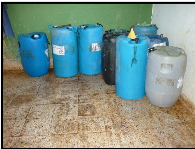
Foto28. Cuarto de almacenamiento de Químicos zona hipoclorito Fuente: Investigadoras
