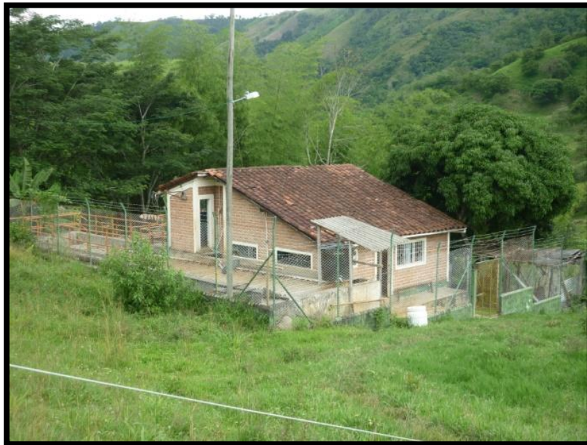
Foto 8. Planta de Tratamiento de Agua Potable Hispania Antioquia Fuente: Investigadora
