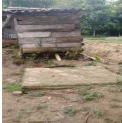
Figura 25. Pozo séptico de una vivienda de la vereda El Guineo, Apartadó, 2015 Ramos, 2015.
