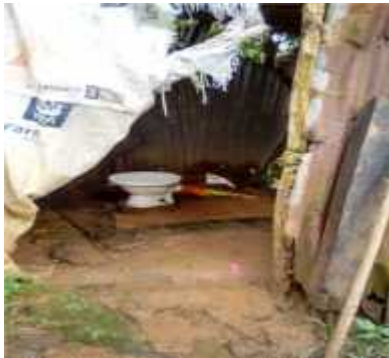
Figura 24. Inodoro sin conexión a un sistema de tratamiento y disposición final de las excretas en una vivienda de la vereda El Guineo, Apartadó, 2015 Ramos, 2015.
