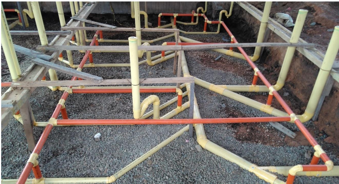
Figura 6 Red de desagües en una edificación
