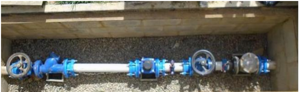
Figura 2 Acometida de un sistema de suministro de agua potable
