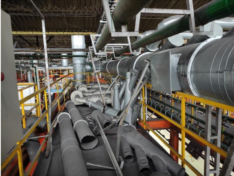
Fig. 2 (b). Mal estado de extractores de humos.
