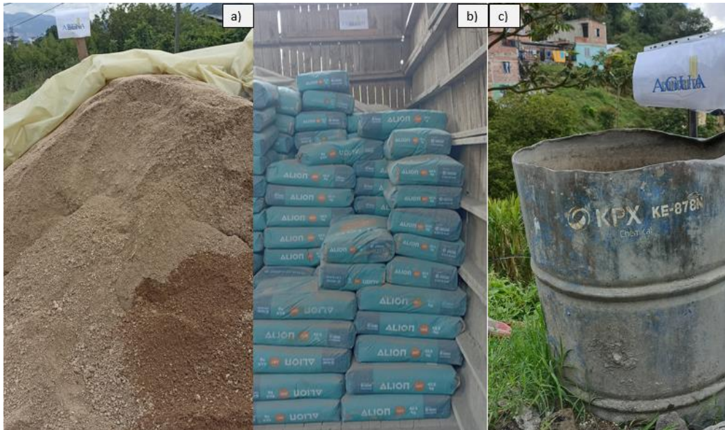
Fig. 5. Almacenamiento de la materia prima: a) arena, b) cemento y c) agua.
