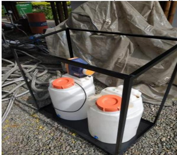
e) Montaje soporte y tanques CIP
