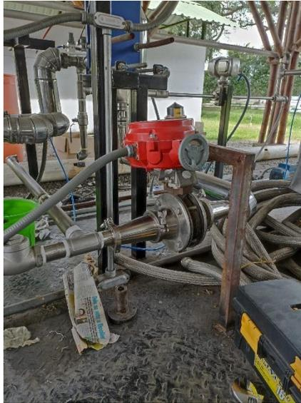
e) Montaje válvula on-off
