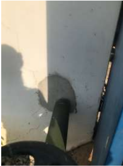
Ilustración 9. Fachada de la edificación Inter-lighting de UG3.0
