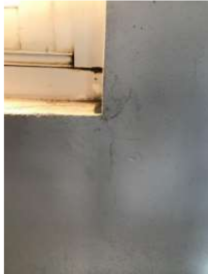
Ilustración 10. Oficina del Edificio Báscula UG3.0
