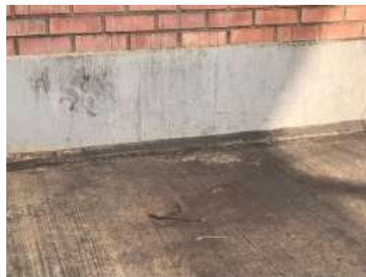
Ilustración 19. Edificio de Transferencia de Carbón UG3.2
