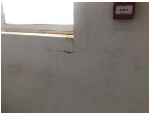
Ilustración 11. Cuarto de Control del Edificio de Estación de Pretratamiento de Agua
