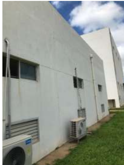
Ilustración 6. Fachada del Edificio de Clorinación UG3.0
