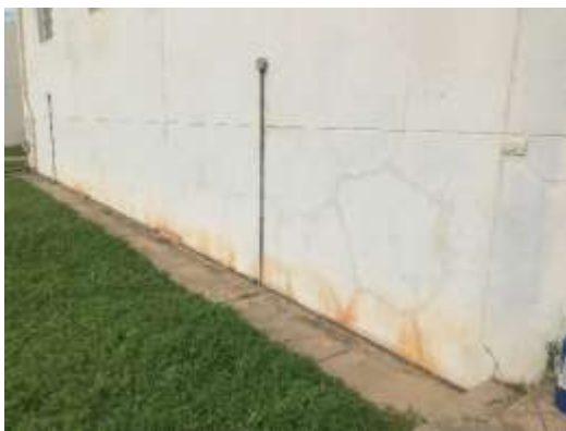
Ilustración 18. Edificio de Recirculación de Aguas UG3.0
