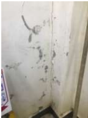
Ilustración 3. Cuarto De Control Operadores del Edificio de trituración de carbón de UG3.0
