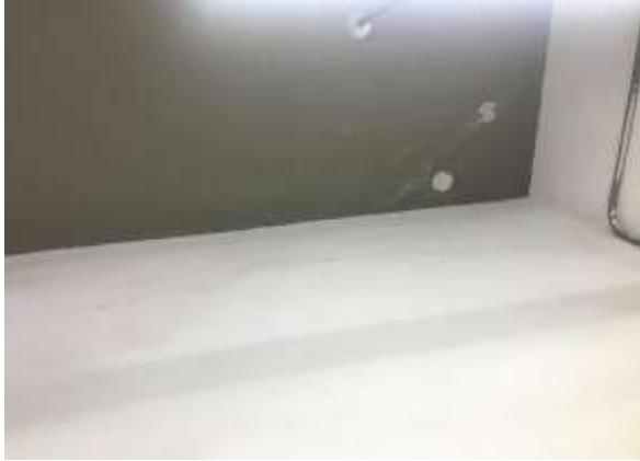
Ilustración 30. Techo Cuarto de Operadores Edificio De Trituración De Carbón UG3.0
