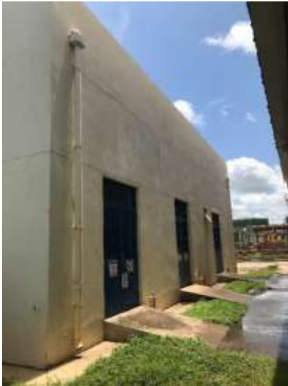
Ilustración 5. Fachada de la Edificación de Caseta de Bomberos UG3.0 3 y UG3.2
