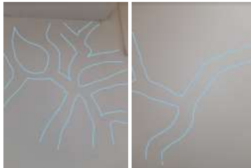
Ilustración 16. Edificio de Viviendas Apartamento 202/sala UG3.2
