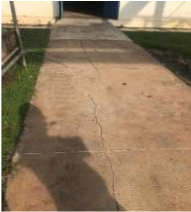
Ilustración 17. Losa de Acceso a la Edificación de Transferencia de Carbón UG3.0
