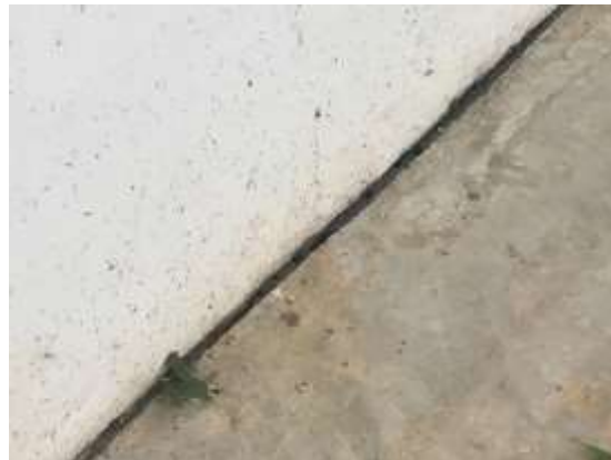
Ilustración 29. Andén de la Edificación Estación Pretratamiento de Aguas UG 3.0
