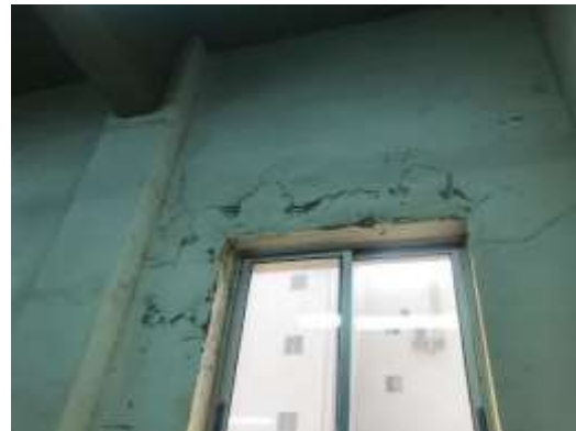
Ilustración 12. Cuarto de Gabinetes I&C del Edificio de Trituración de Carbón de UG3.0
