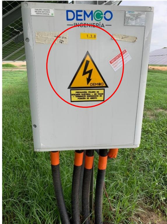
En la **(Figura 13)** se muestra la subsanación a las no conformidades 19, 20, 23, 24 y 25, diagrama unifilar, frente muerto y código de colores en las cajas combinadoras.
