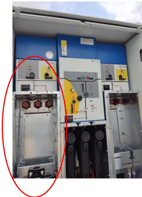
La (**Figura 6**) presenta la instalación de terminales premoldeados y finalización de conexión de conductores de media tensión a 13,8kV en celdas de entrada y salida, evidencia la adecuada identificación del código de colores en los conductores y el espacio de trabajo de 1,5 metros frente a celdas de CT1, dando subsanación a las no conformidades 8, 9 y 10 de la (**Tabla 1**)
