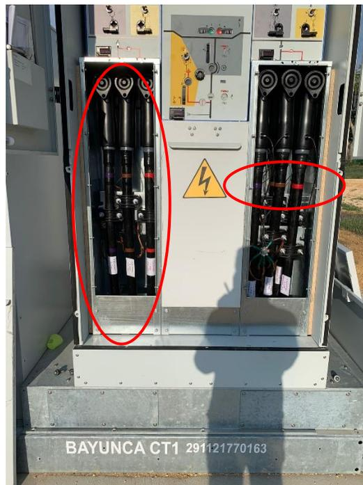
A continuación, en las (**Figura 7, Figura 8,** ) se presenta la subsanación a las no conformidades 11, 12, 13 y 14 del centro de transformación donde se muestra; anclaje de las estructuras de soporte de los equipos en los centros de transformación, marquillas de identificación de equipo, cinta de precaución para conductores con enterramiento directo y límites de aproximación a equipos energizados.
