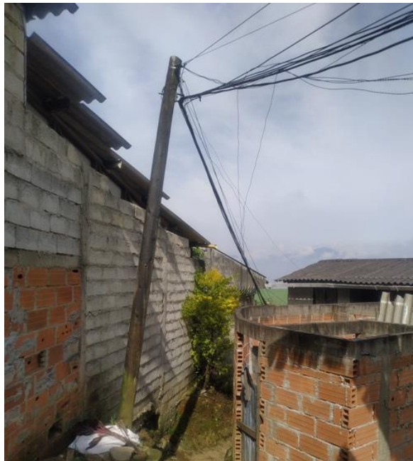
Fig. 12. Evidencia de luminaria no existente en campo.
