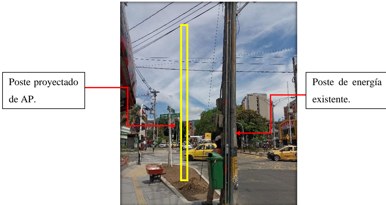
Fig. 38. Evidencia de duplicidad de infraestructura en obra.
