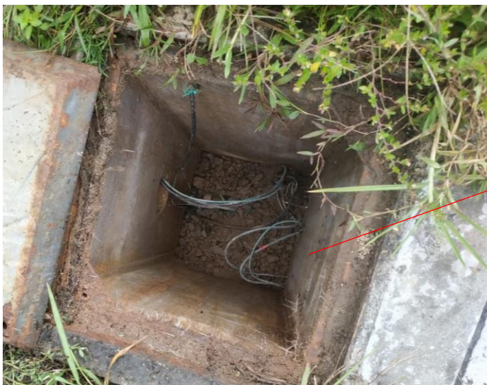
Fig. 28. Evidencia de profundidad inadecuada de caja en inspección de obra.
