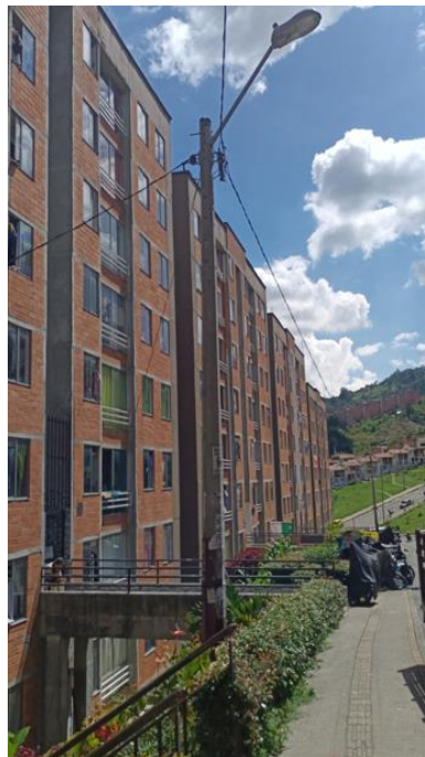
Fig. 21. Evidencia de luminaria inexistente en visita de campo.
