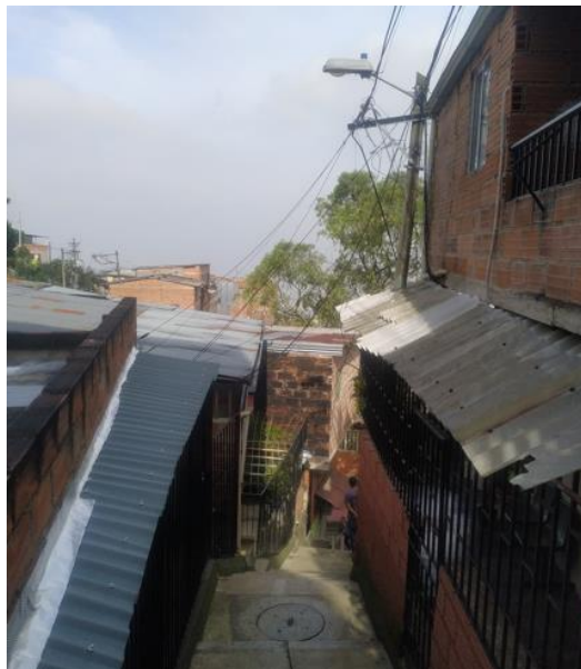
Fig. 14. Evidencia de punto luminoso no existente en campo.
