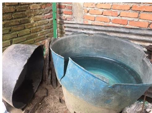
**Figura 34. Tanques abastecimiento de agua sin tapa a la intemperie.**
