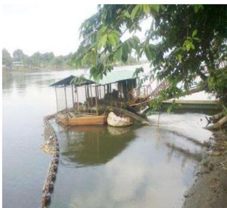
**Figura 3 Sistema de captación de agua**
