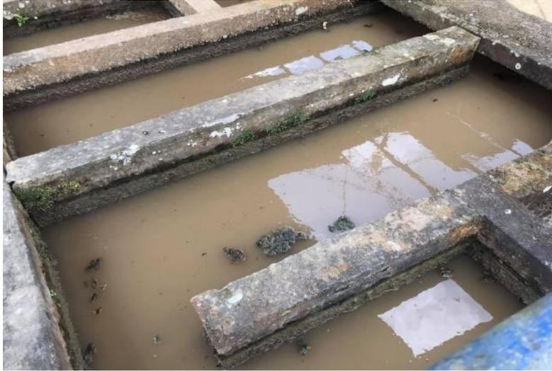
**Figura 6 Tanque de coagulación y floculación**
