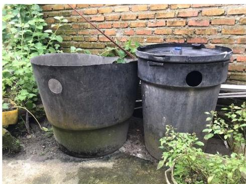
**Figura 33. Tanques almacenamiento agua a la intemperie sin y con tapa.**
