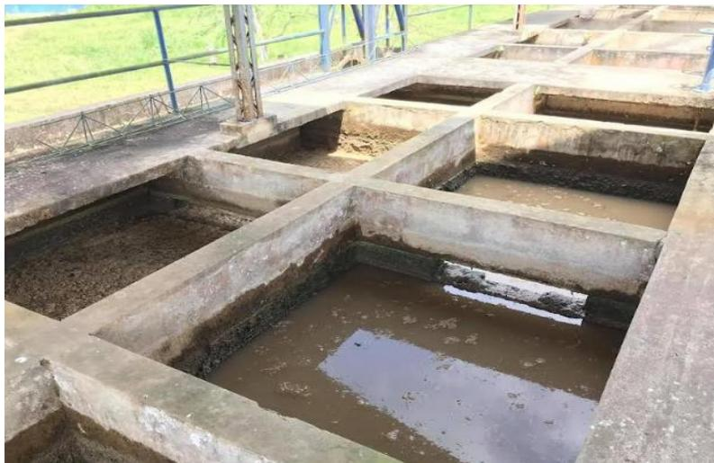
**Figura 7 Tanque de coagulación y floculación**
