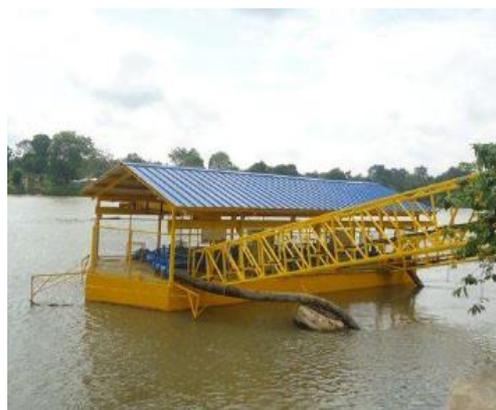
**Figura 4 Sistema de captación de agua**
