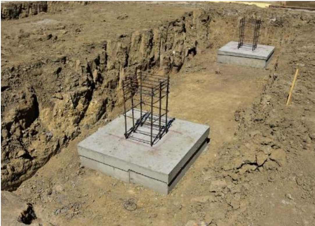
Figura 10. Ejemplo zapata aislada. Fuente: El autor
