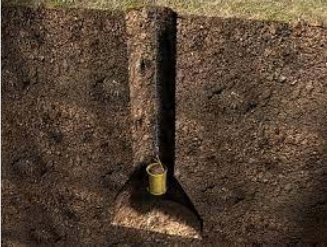
Figura 10 Excavación campana.
