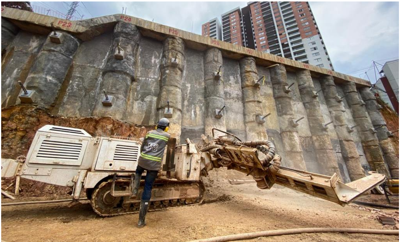
Figura 20 Perforación para drenes.
