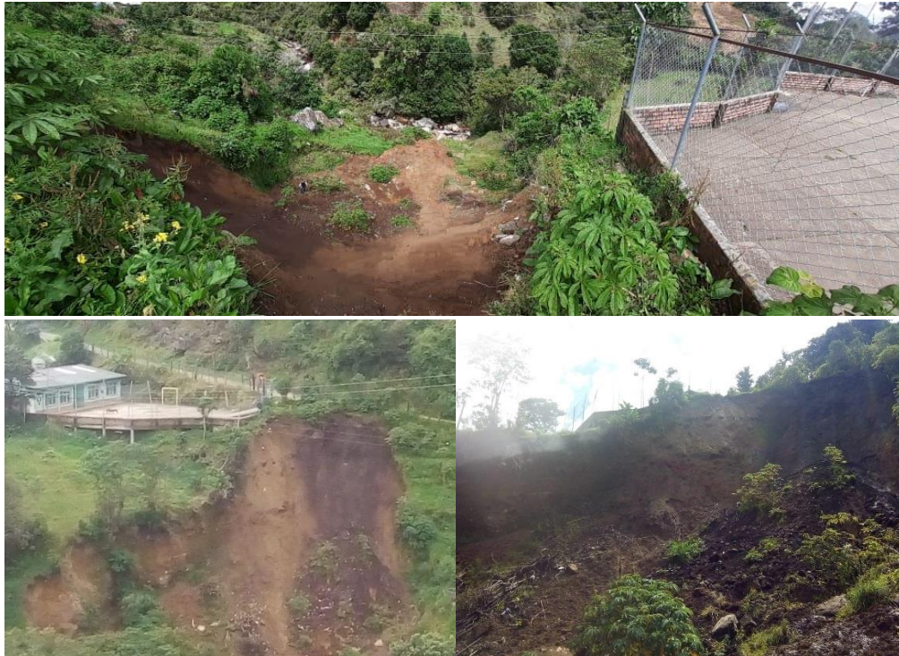
Figura 8. Deslizamiento ocurrido en el Centro Educativo en el corregimiento de los Milagros Bolívar Cauca -Elaboración propia.
