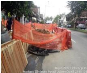
Seguimiento a Almacenamiento de Materiales que no genere afectación sobre la Calzada y Andén
