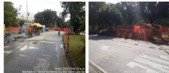
Foto 21. Zona de trabajos Sector Bomberos Etapa 26A y 26B/ Etapa 33 y 35 Sector TCC
