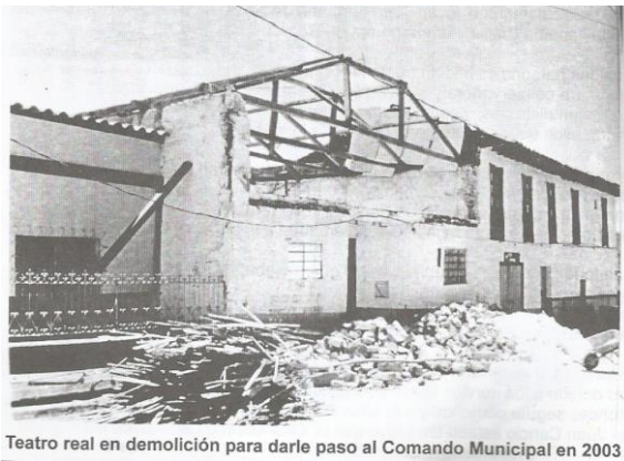
Foto 3. Demolición de teatro real
